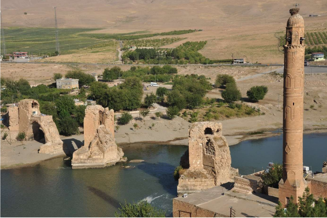
Resim 8 Hasankeyf Köprü Ayakları
