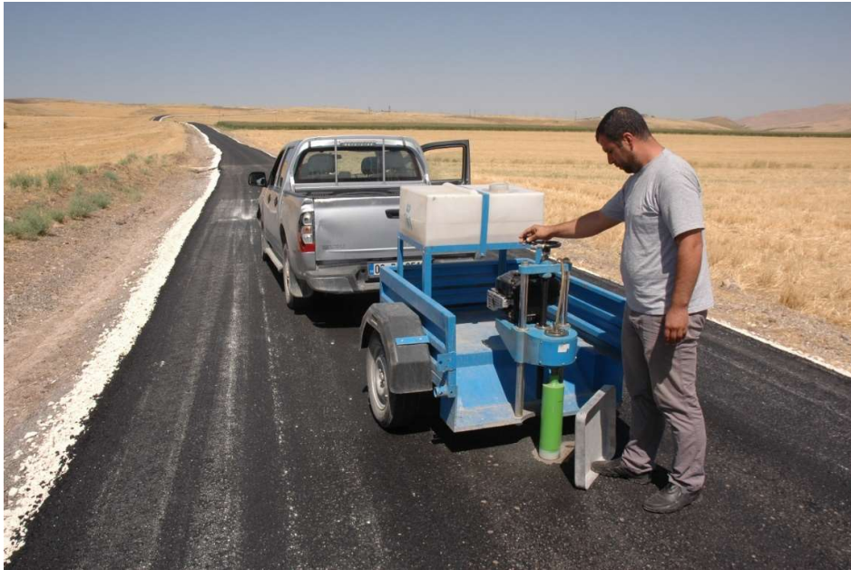
Resim 12 Yol Çalışmalarından Bir Görüntü
